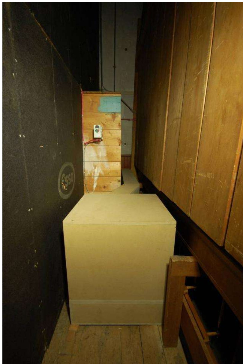
1-Soufflerie: nouvelle boîte de moteur et bras de pompes avec jauge
